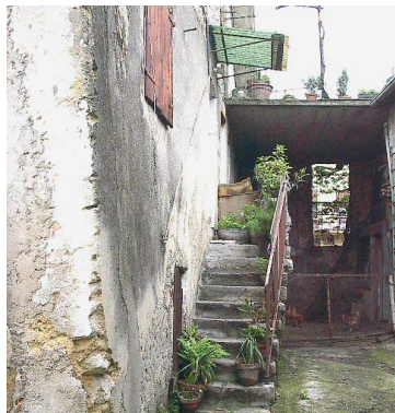
SCALA IN PIETRA CON PARAPETTO IN FERRO DI DISEGNO SEMPLICE
