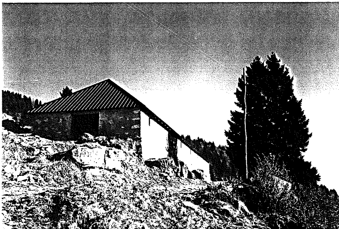
Foto c - il tetto della stalla e' a padiglione con una sporgenza ridotta delle falde lungo tutti i lati del fabbricato.
