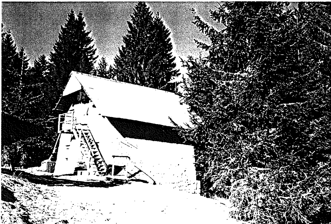
Foto b - nel casello la linea di colmo del tetto e' posta perpendicolarmente ai fronti principali, che sono caratterizzati da timpani in legno, le falde sporgono lungo tutti i lati e la pendenza e' maggiore rispetto agli altri fabbricati.
